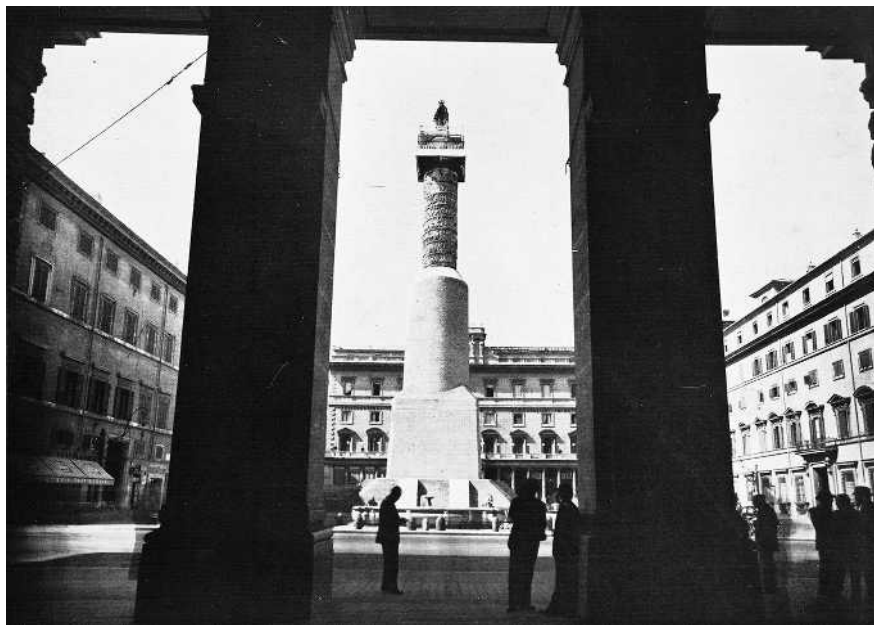
Figure 1. Rome: Piazza Colonna after completion of anti-aircraft protection works on the Antonine Column. Direzione Generale delle Arti, 1942.
