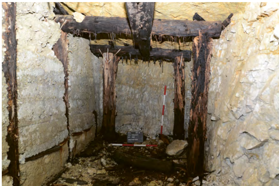
10 Strutture lignee nella caverna di sinistra del Sexten Alto. Il cemento visibile sulla parete sinistra ottura delle feritoie che prima dei lavori di maggio-giugno 1917 guardavano verso Calotta Ovest. Foto di documentazione scattata durante la campagna di rilievo del progetto "Written in the Landscape" nell'estate 2021. © 2021, unibz, WiL Archive. Riproduzione autorizzata.
