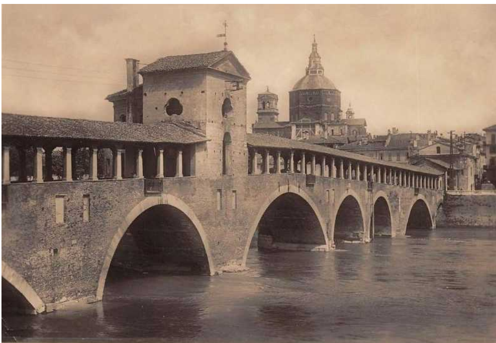
Figure 34. Pavia, Ponte Coperto, 14th c. ©2023 Francesco Salvestrini.
