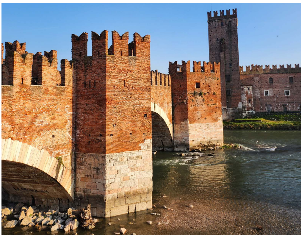
Figure 30. Verona, Ponte Scaligero or 'di Castelvecchio', 14th c. ©2023 Francesco Salvestrini.
