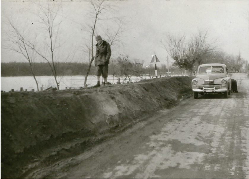
Figure 6.2 Emergency dam at Dunavecse in 1956. Source: Dénes Ihrig, "Gátvédelem és korszerűsítésének kérdései," Vízügyi Közlemények 45, no. 3 (1963), 255.
